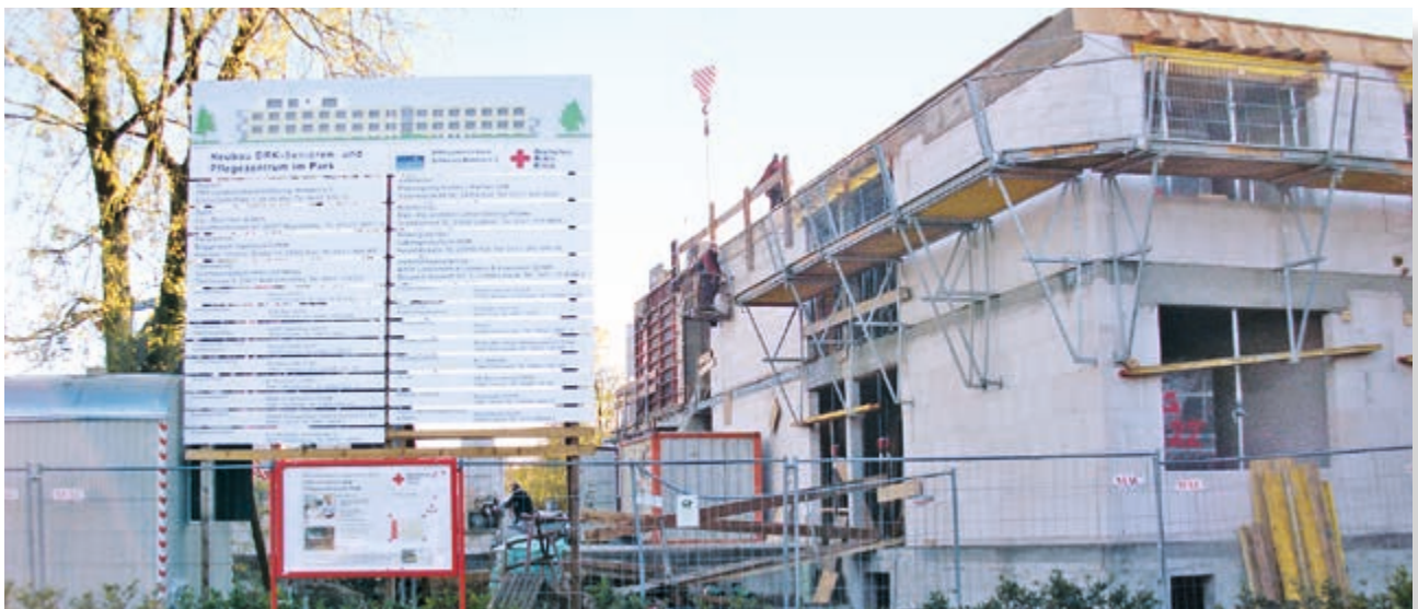
Ersatzneubau in Lübeck: Fertigstellung Anfang 2014
