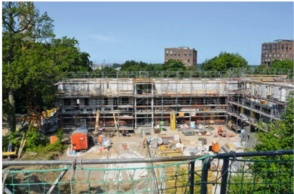
Baugrube in Lübeck: Beginn der Bauarbeiten für das neue DRK-Senioren- und Pflegezentrum im Park
